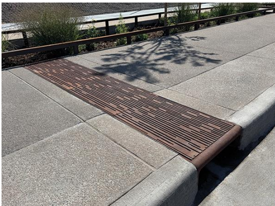
Figure 5.10 Entrée d'eau pluviale sur le trottoir
