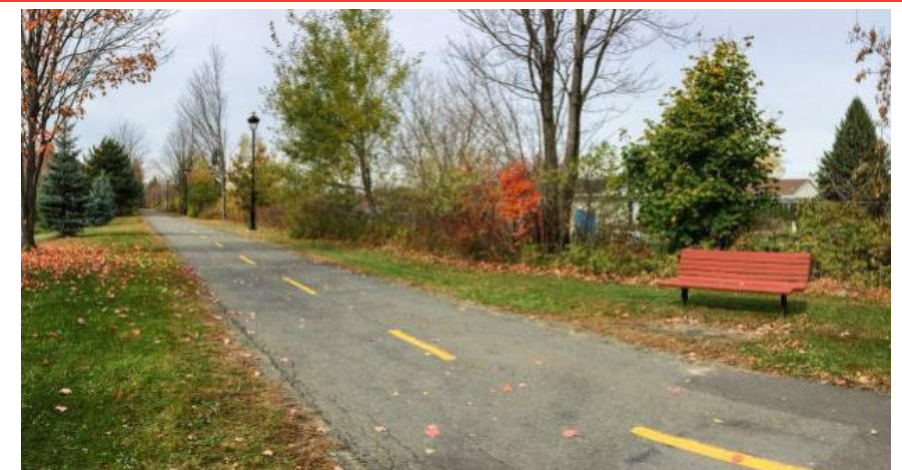
Figure 4.17 Chaussée à circulation douce (« chaucidou »)
