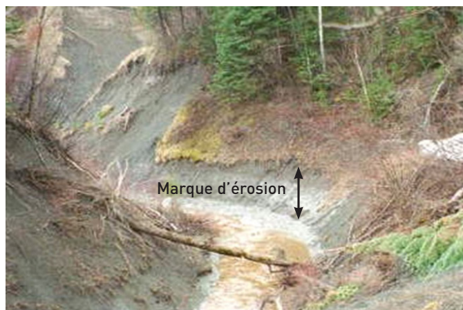
Figure 4 | Marque d'érosion à la base d'un talus
