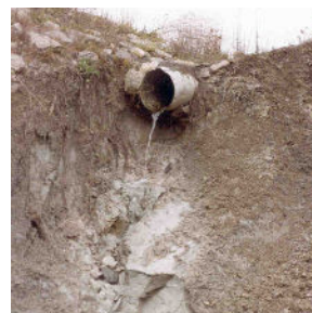
Figure 20 | Exemples d'interventions qui ont pour effet de provoquer une concentration d'eau pouvant nuire à la stabilité d'un talus : A) ravinement provoqué à la sortie d'un ponceau; B) érosion verticale provoquée à la sortie d'un drain; C) infiltration d'eau dans le sol due à un champ d'épuration
