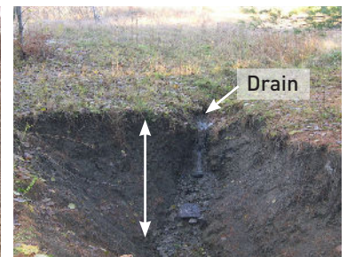
Figure 20 | Exemples d'interventions qui ont pour effet de provoquer une concentration d'eau pouvant nuire à la stabilité d'un talus : A) ravinement provoqué à la sortie d'un ponceau; B) érosion verticale provoquée à la sortie d'un drain; C) infiltration d'eau dans le sol due à un champ d'épuration
