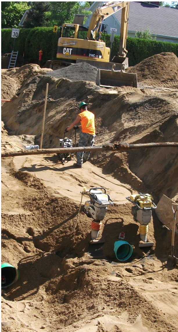
Installation de conduites
